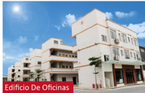
Edificio De Oficinas
